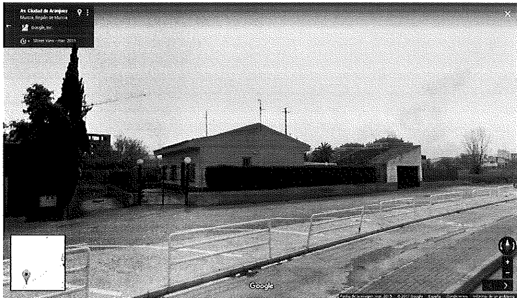
Vivienda afectada de Avenida Ciudad Aranjuez, n° 66 de Zarandona, Murcia
