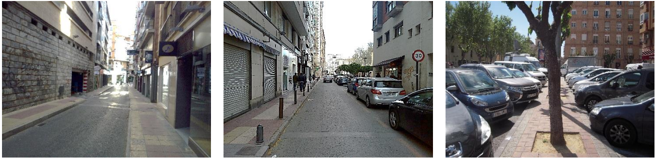
Aceras estrechas y mermadas con bolardos y alcorques
