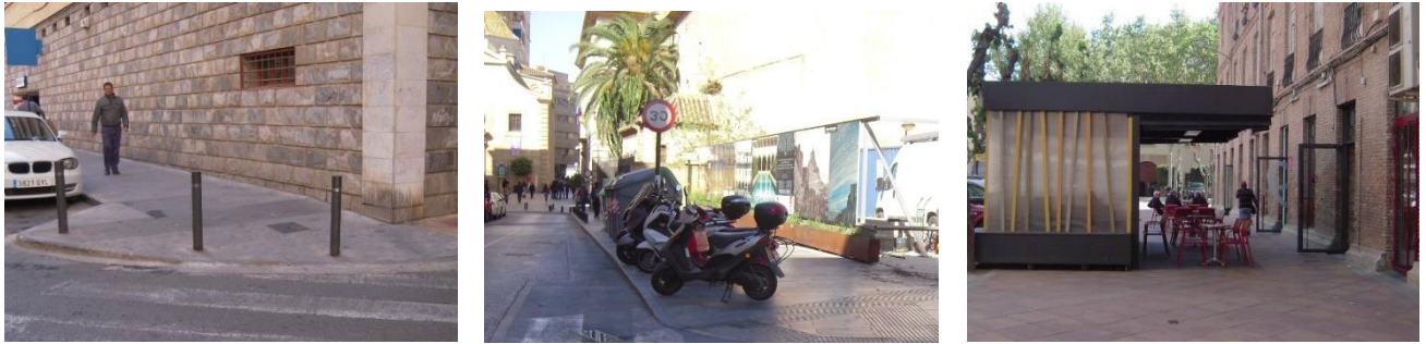
Itinerarios peatonales obstaculizados por bolardos, vehículos e instalaciones de hostelería
