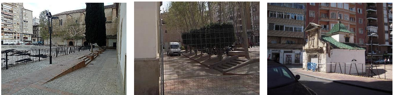
Diferencia de cota en el Palacio de San Esteban y en la Capilla del Vía Crucis
