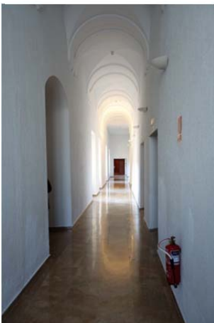
9.5. Pasillo del ala oeste, junto al Patio Norte. Planta baja
