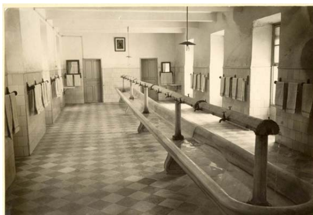
8.13. Imagen del interior de la antigua Casa de la Misericordia
