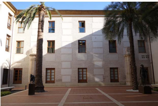
9.15. Patio Norte. Fachada sur
