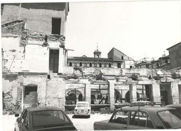
8.5. Vista desde Callejón Burruezo hacia la fachada oeste del complejo del Colegio. En primer plano se observa el antiguo Patio que comunicaba con el que hoy conocemos como Patio Sur o Patio Principal. Hacia 1975
