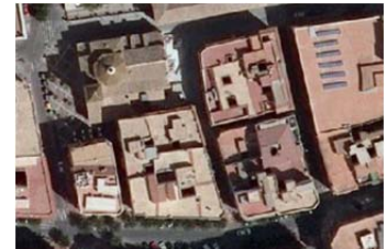
2007 (cambio de pavimento)
