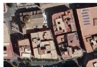
2007 (cambio de pavimento)
