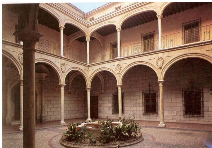
8.15. Patio Sur. Imagen previa a la intervención de los años 1982-1985
