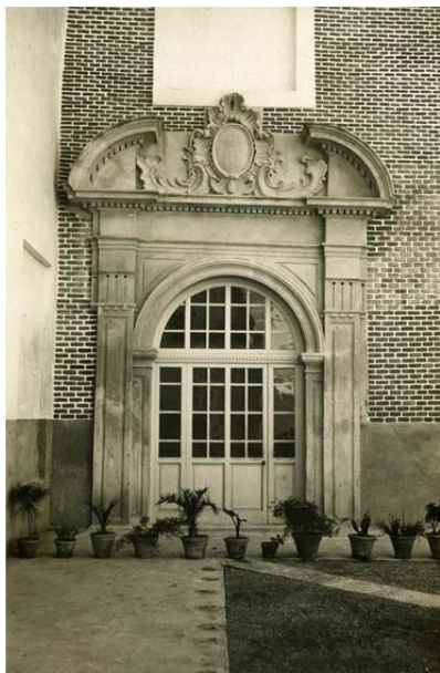
8.9. Portada del ala oeste del Patio Norte. Imagen previa a la reforma integral de los años 80.
