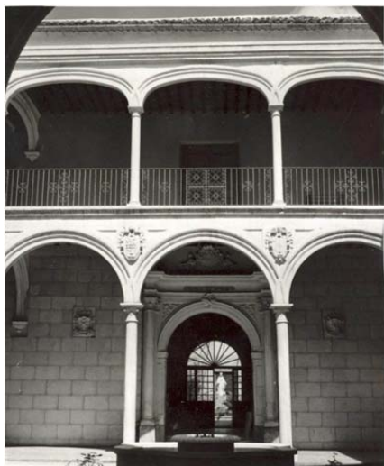
8.14. Patio Sur. Imagen previa a la intervención de los años 1982-1985
