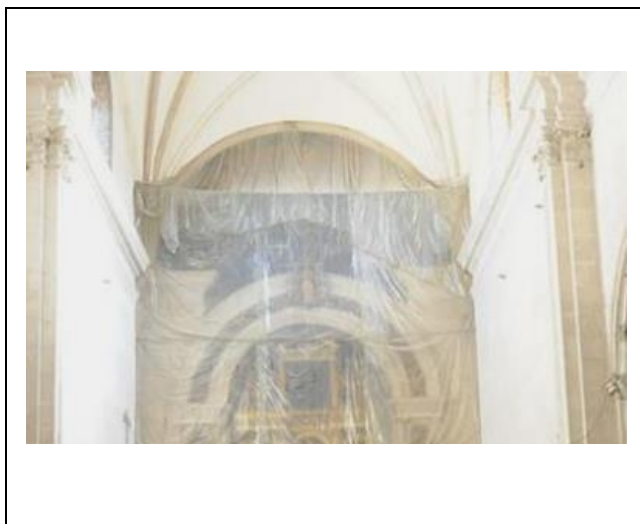
Pinturas murales del ábside (estado actual)
