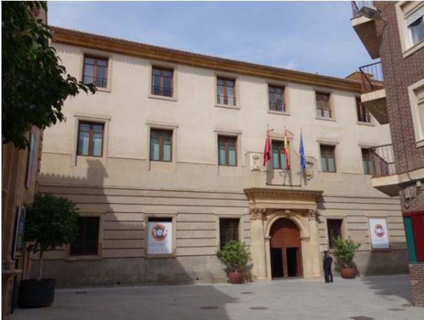
9.1. Fachada principal. Calle Acisclo Díaz
