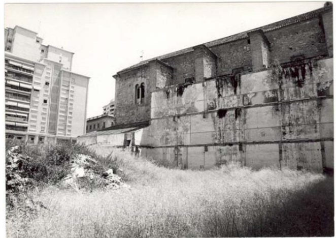
8.2. Vista de la fachada norte de la Iglesia de San Esteban en la que se aprecian los restos medianeras de los antiguos pabellones anexos, hacia 1975
