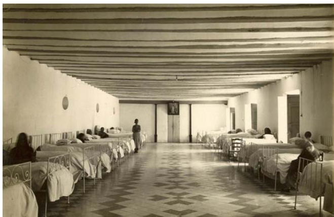
8.12. Imagen del interior de la antigua Casa de la Misericordia
