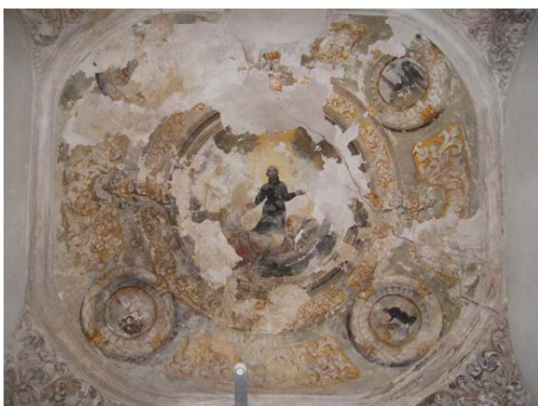
9.12. Bóveda de la Capilla del lado de la epístola
