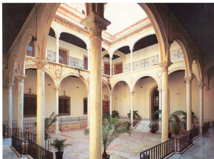
8.16. Patio Sur. Imagen tras las obras de reforma de 1982-1985. Se rebaja el nivel central, manteniéndose un ándito elevado perimetral
